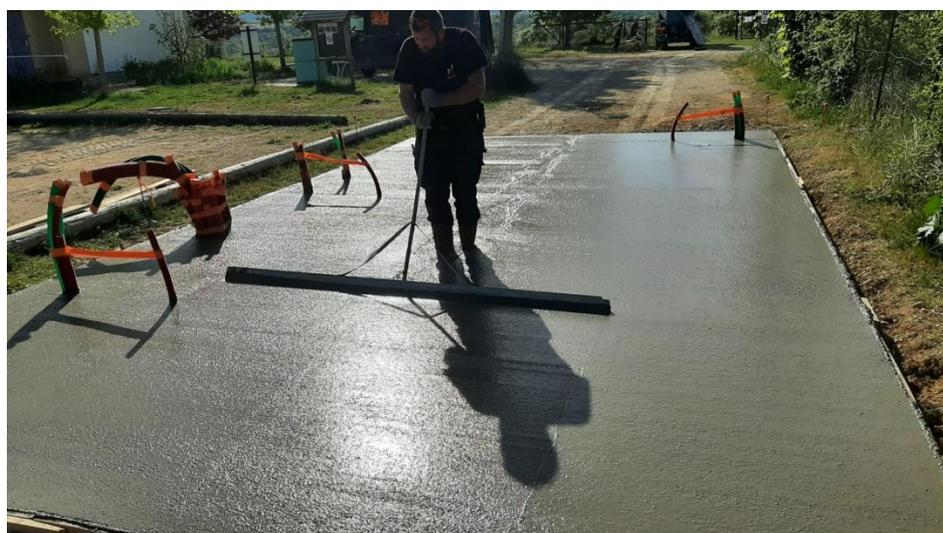
Les travaux de rénovation de notre aire de camping-car sont en cours. Une dalle de béton a été coulée pour servir de support à la borne de contrôle d'accès à l'aire. De même pour les plots qui supporteront les 10 bornes électriques.
